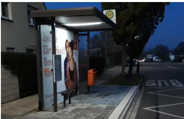
Abb. 31: Kap-Haltestelle mit vorgelagerter Grünfläche, Oberasbach Albrecht-Dürer-Platz, Lkr. Fürth: der Fahrgastunterstand ist direkt beleuchtet.
