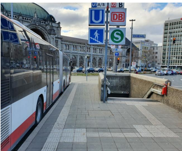
Abb. 27: Haltestelle Nürnberg Hauptbahnhof, Steig D Vom Bussteig führt das Blindenleitsystem unterirdisch zu den U-Bahnen und Zügen sowie oberirdisch zur Straßenbahn und in Richtung Altstadt.
