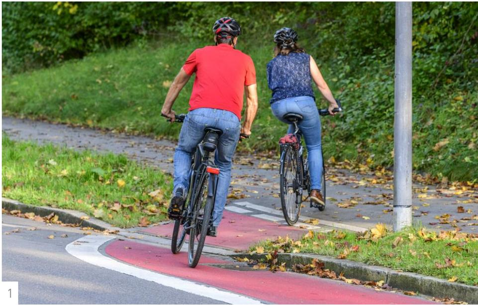
Bei den Überleitungen zwischen verschiedenen Führungsformen müssen Sie auf ausreichende Radien achten. Werden diese zu eng bzw. zu klein gewählt, ist kein flüssiges Radfahren mehr möglich.
