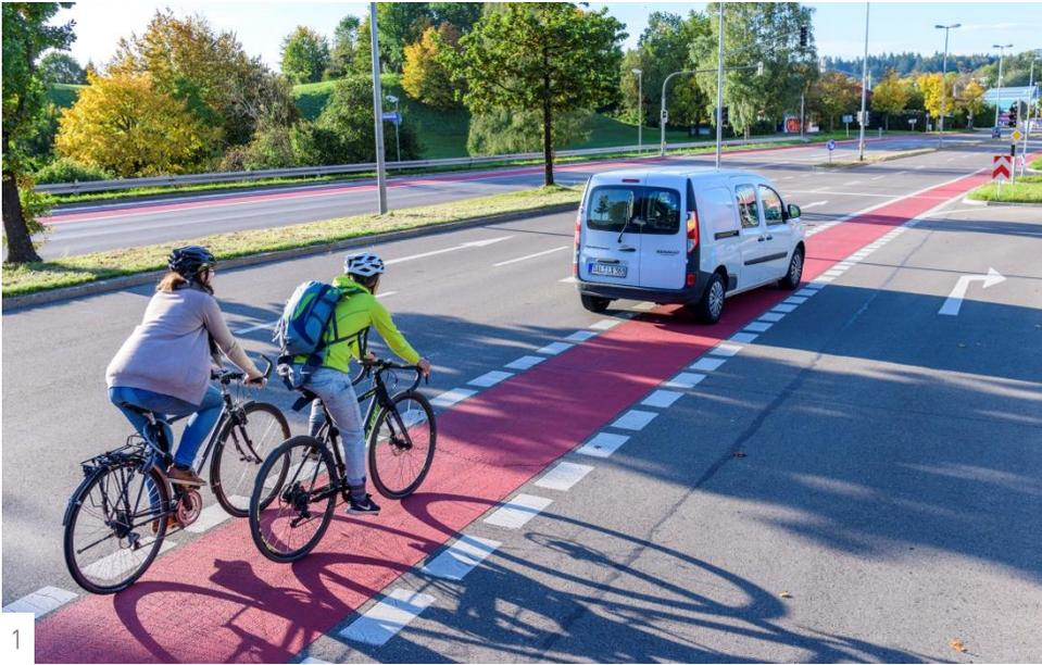
Im Bereich von Einmündungen und Abzweigungen wird die ansonsten durchgezogene Breitstrichmarkierung unterbrochen. Der Kfz-Verkehr darf hier den Radfahrstreifen zum ein- und abbiegen überfahren. Das Bild links zeigt eine solche Situation.
