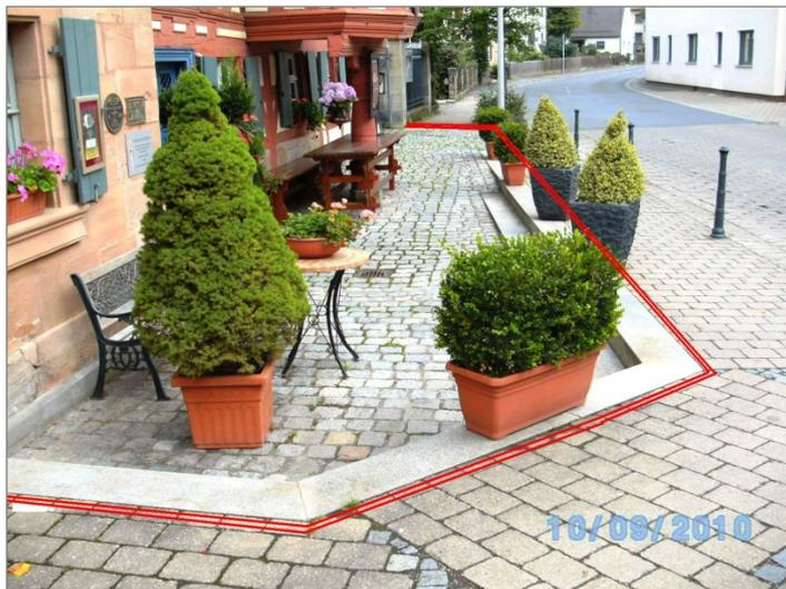
Bild 4: möglicher Einbau von Entwässerungsrinnen um den Bereich des Eingangsportals mit Anschluss an den Regenwasserkanal
