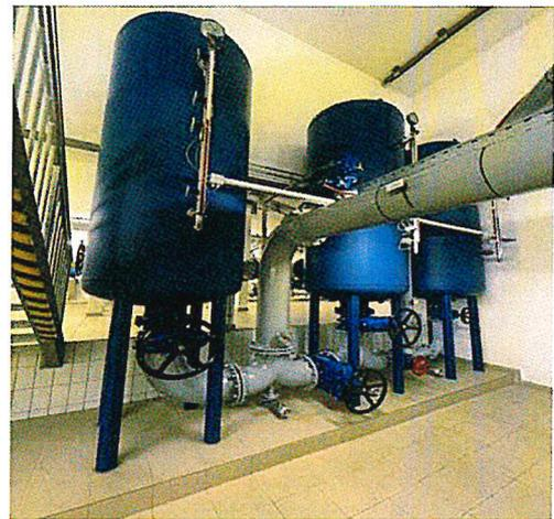
Die Rückspülung der Filter wird manuell in Betrieb gesetzt und durchgeführt. Die Spülung der Filter erfolgt einmal pro Woche, alle Filter werden nacheinander gespült.
