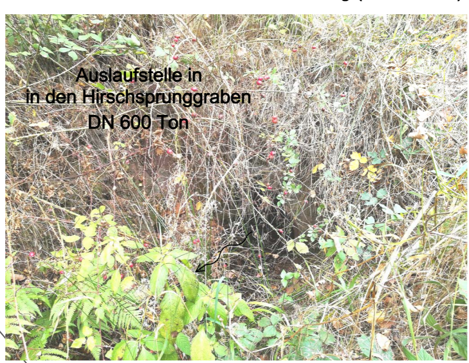
Station 0+183.70 : Auslauf Entleerleitung (22.10.2018)
