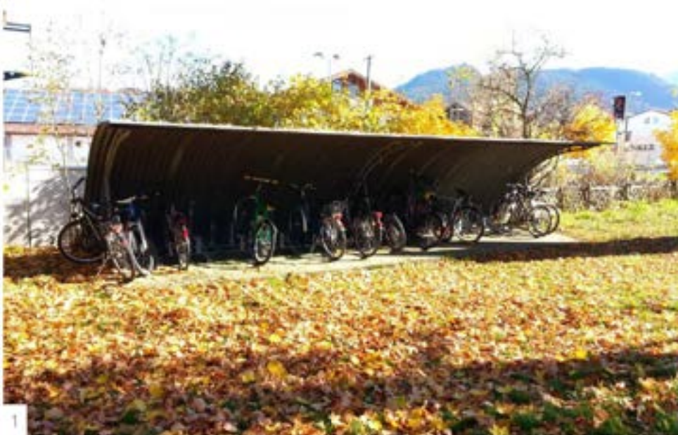
Bild 1: Diese Abstellanlage an einem Bahnhof ist im Grunde eine Insel, die ringsum von Grünflächen umgeben ist. Es existiert keine Zufahrt. Gerade bei nasser Witterung sehr ärgerlich.
