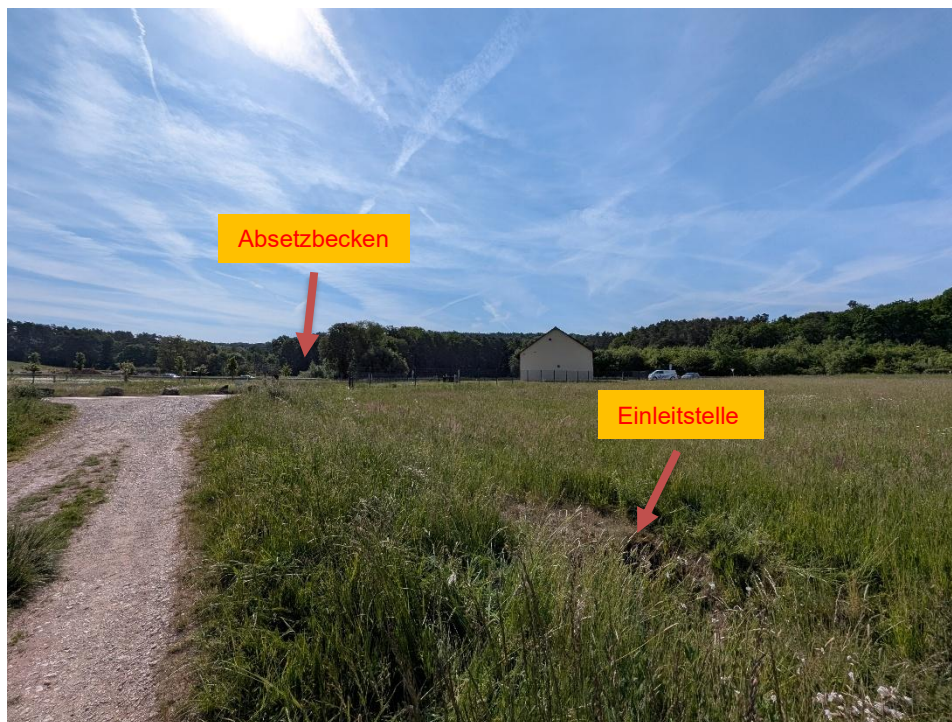
Abbildung 10: Ausgehend von der Einleitstelle (Blickrichtung Wasserwerk Bubenreuth)
