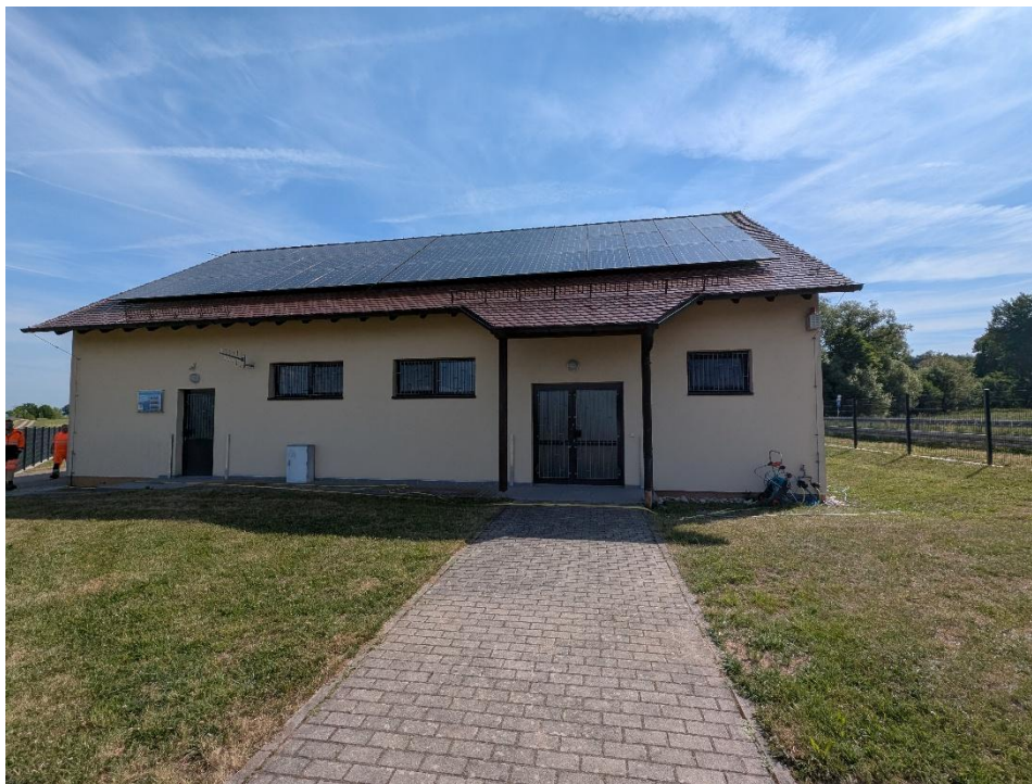
Abbildung 1: Wasserwerk Bubenreuth (Außenansicht)
