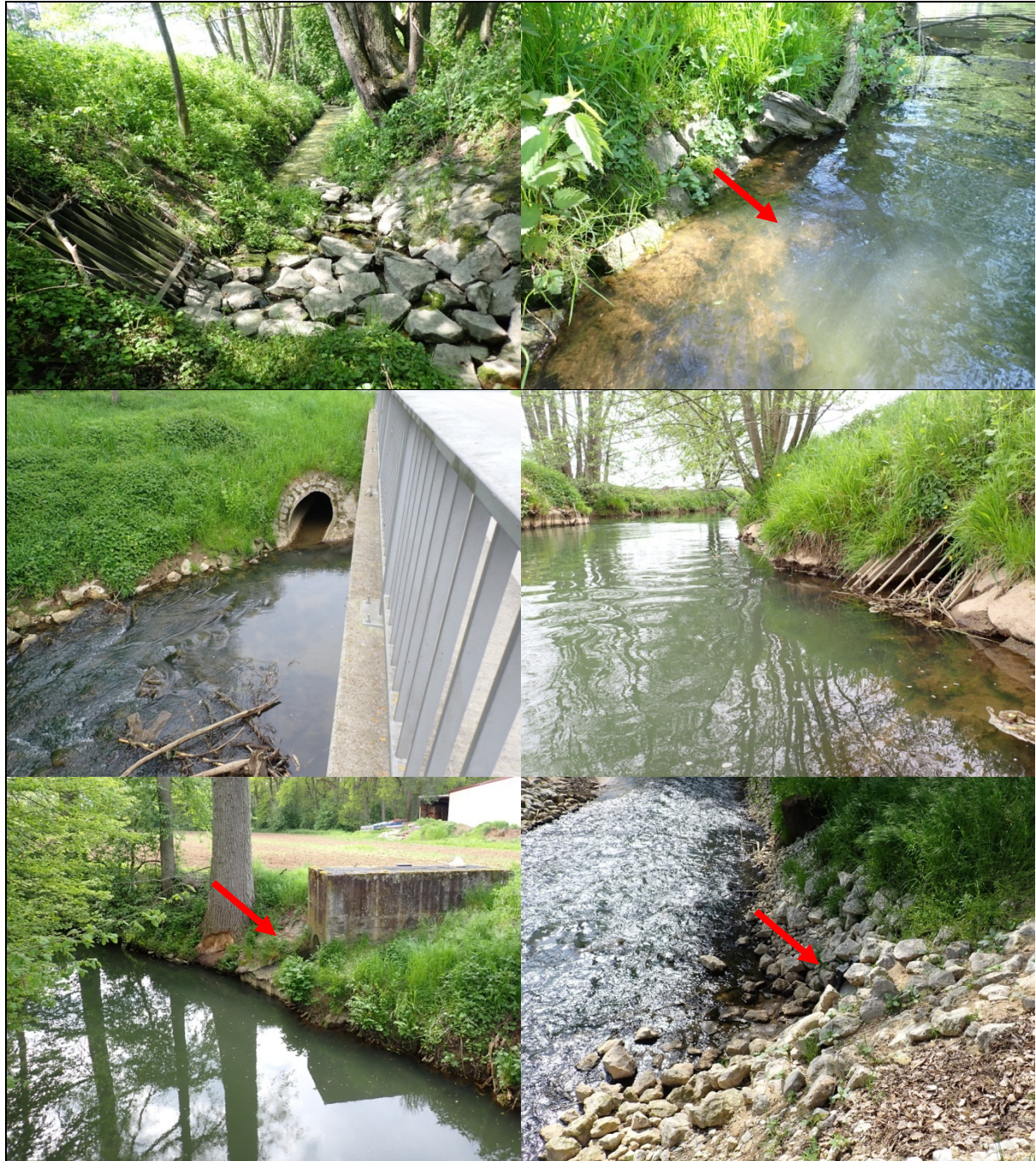
Abb. 57: Einleitbauwerke SKO 5b und SKU 8a (oben links bzw. rechts), RÜB 8 und SKZ 10 (Mitte links bzw. rechts) sowie DLB 16_SKO 18 und RÜB 20a (unten links bzw. rechts) an der Schwabach im Mai 2023.
