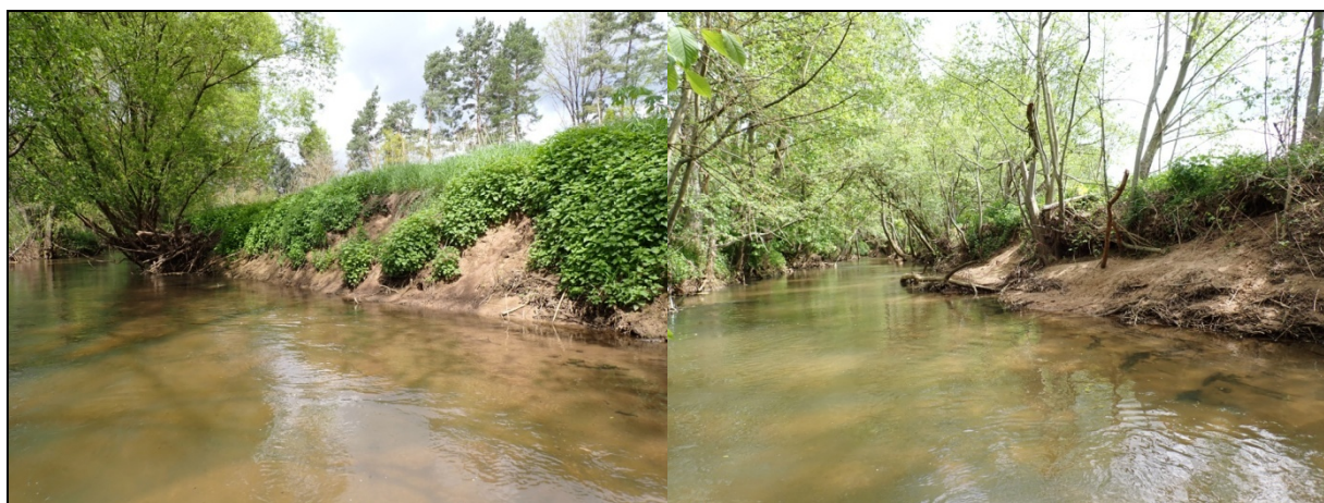
Abb. 61: Ufererosionen flussab von DLG 29 im Mai 2023.
