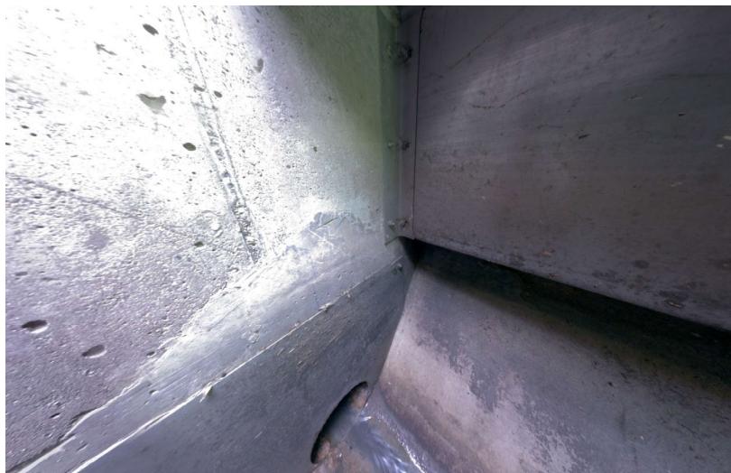
Abbildung 2: Bestand RÜ Untermembach Drosselblende / Tauchwand
