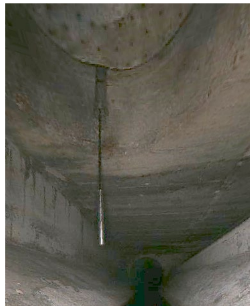
Abbildung 7: Tauchsonde im RÜ 1
