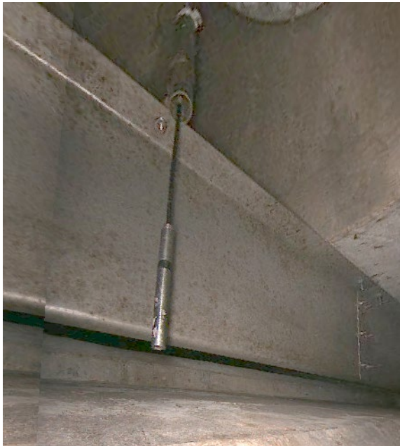
Abbildung 8: Tauchsonde im RÜ 2
