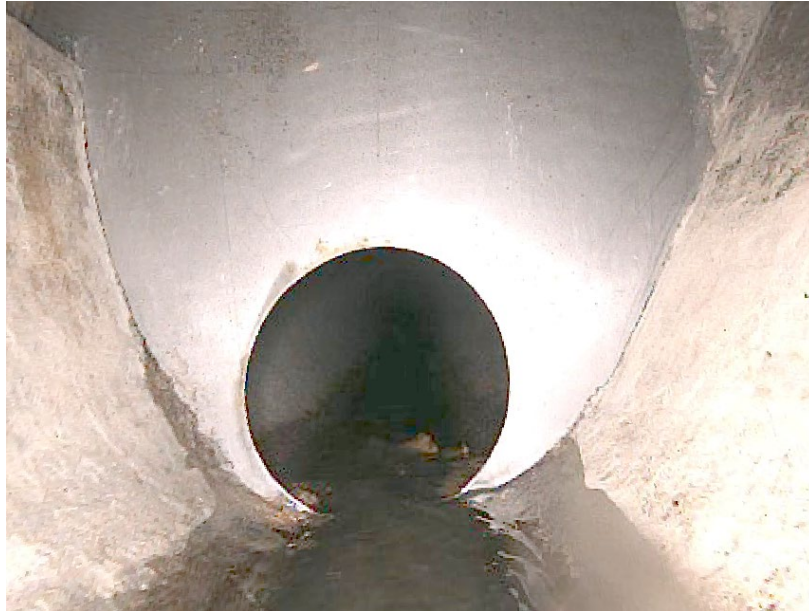
Abbildung 3: Bestand RÜ Untermembach - Drosselblende DN 220
