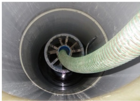
Absaugvorgang durch das Wartungsrohr
