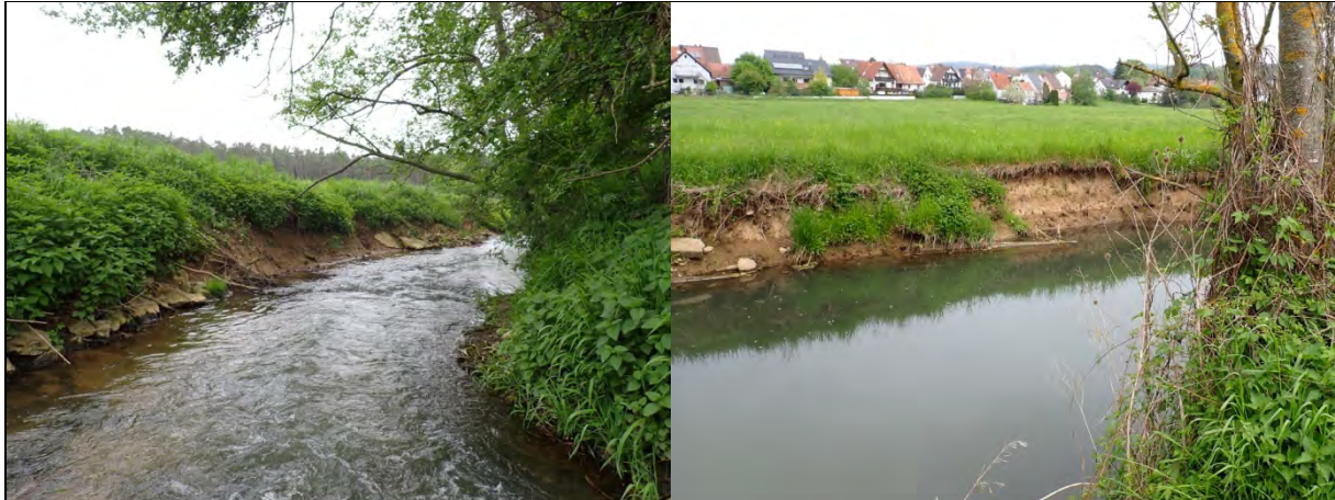
Abb. 60: Ufererosionen unmittelbar unterhalb der Sohlgleite bei RÜB 8 im Mühlkanal der Sendelmühle (links) und unterhalb von SKZ 10 (rechts) im Mai 2023.
