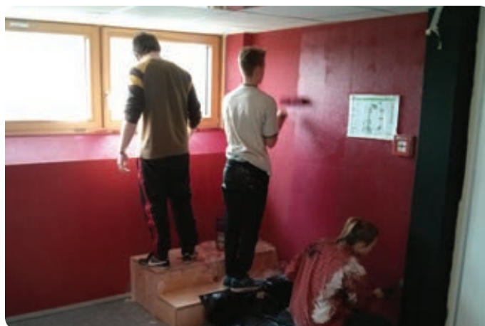
Die Renovierung von Jugendräumen in Baiersdorf wurden 2015 mit 700 € gefördert (Kleinrenovierung).
