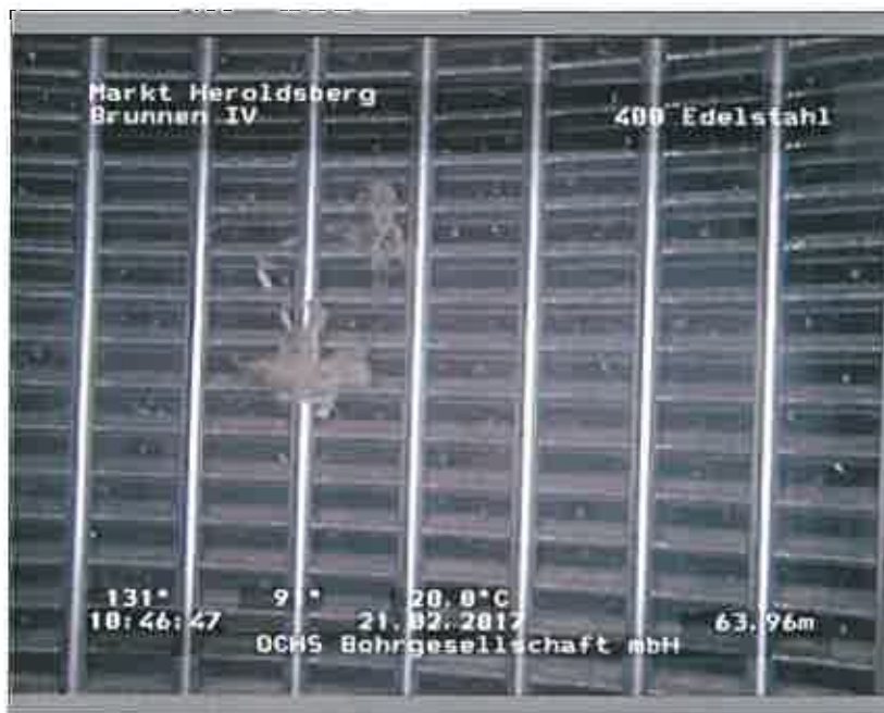
Foto: 104908_A.JPG, 00:10:52 63,96m, Filterschlitze offen, Glaskugeln sichtbar
