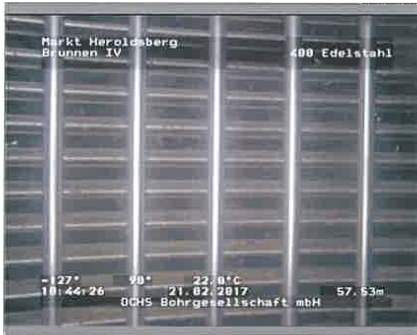
Foto: 104646_A.JPG, 00:08:36 57,53m, Filterschlitzte offen, Glaskugeln sichtbar
