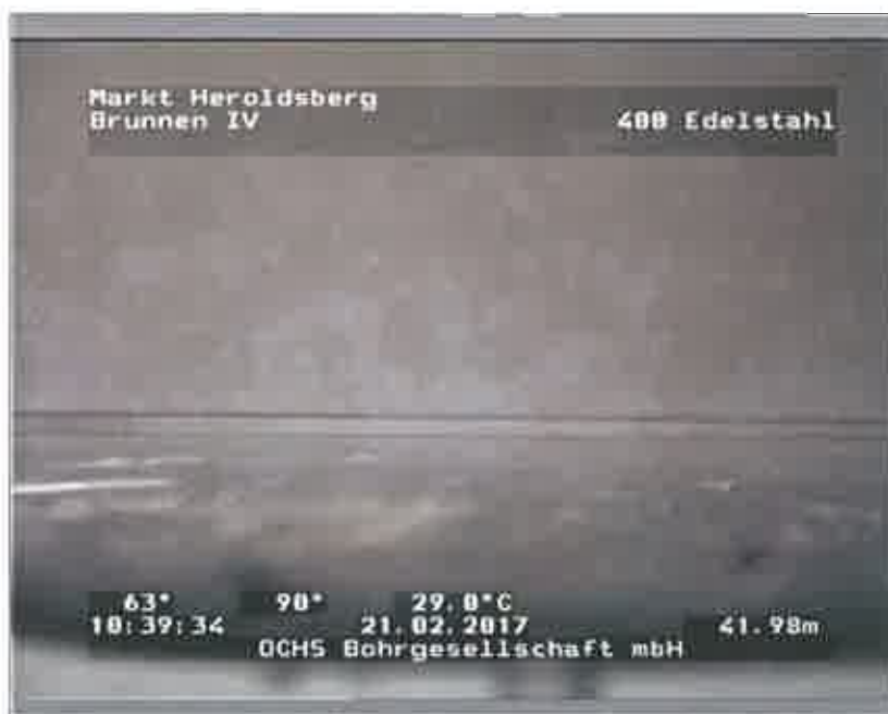
Foto: 104154_A.JPG, 00:03:53 41,98m, OK Wasserspiegel in Ruhe
