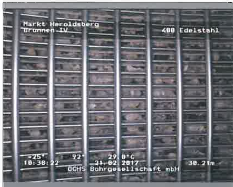
Foto: 104043_A.JPG, 00:02:46 30,21m, Filterschlitze offen, Filterkies sichtbar
