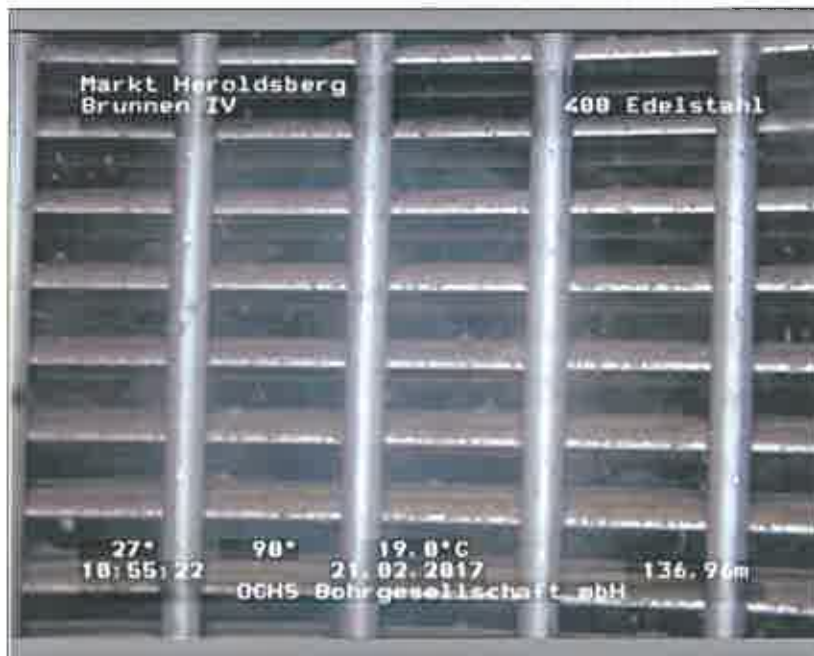
Foto: 105742_A.JPG, 00:18:57 136,96m, Filterschlitze offen, Glaskugeln sichtbar
