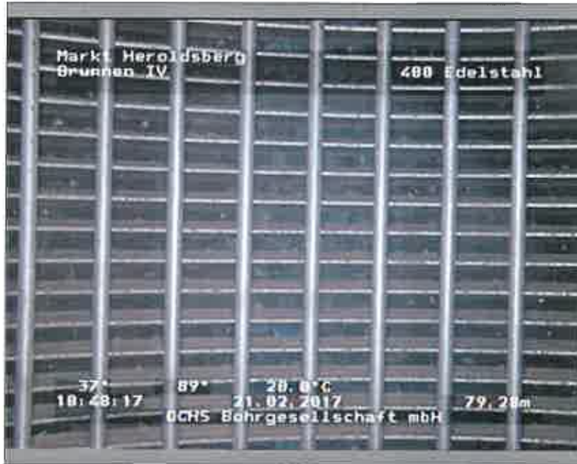
Foto: 105037_A.JPG, 00:12:14 79,28m, Filterschlitz offen, Glaskugeln sichtbar
