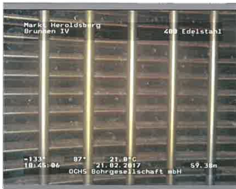
Foto: 104727_A.JPG, 00:09:14 59,38m, Filterschlitzte offen, Glaskugeln sichtbar
