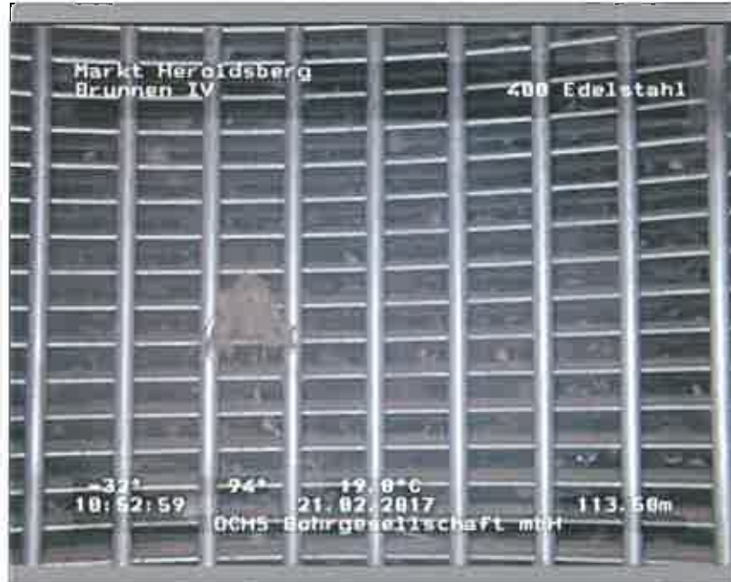
Foto: 105519_A.JPG, 00:16:45 113,5m, Filterslitze offen, Glaskugeln sichtbar
