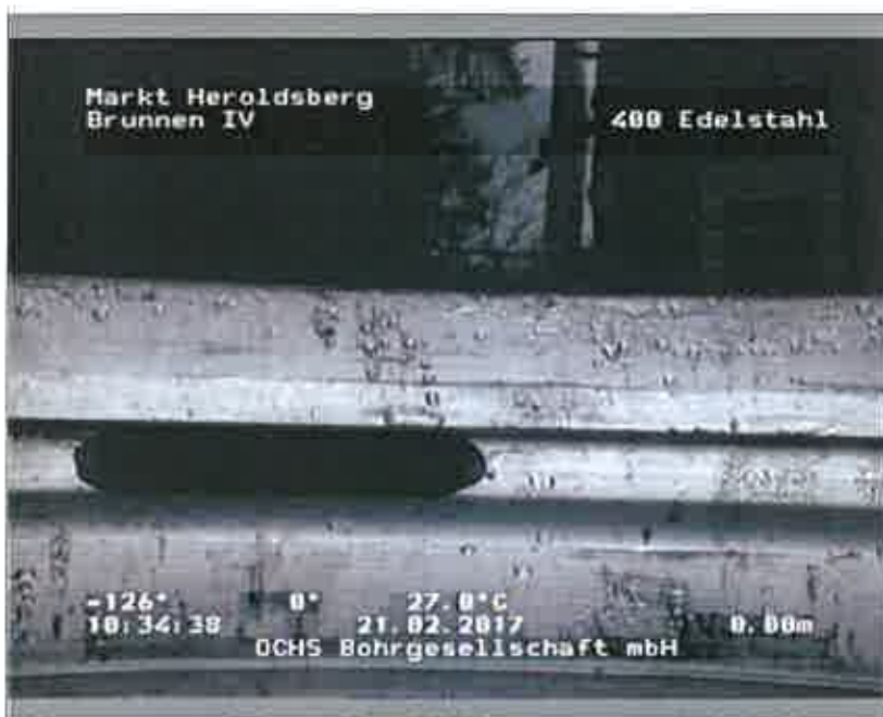
Foto: 103657_A.JPG, 00:00:00 0m, OK Vollrohr
