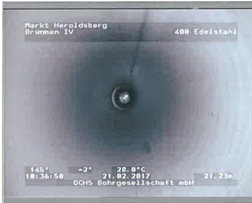
Foto: 103910_A.JPG, 00:01:27 21,23m, Blick ins Vollrohr, ablagerungsfrei
