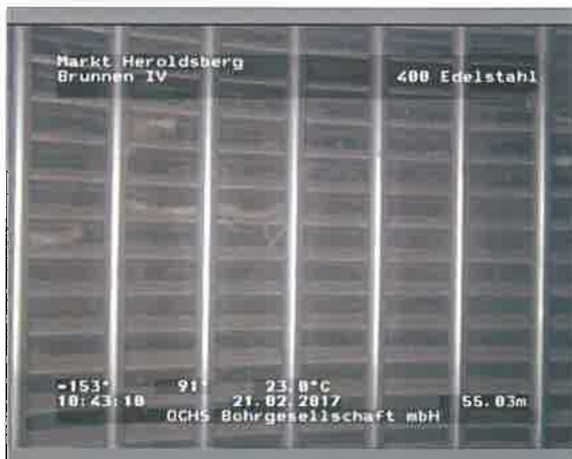
Foto: 104530_A.JPG, 00:07:23 55,03m, Filterschlitz offen, Glaskugeln sichtbar
